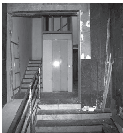
Estado de las obras
