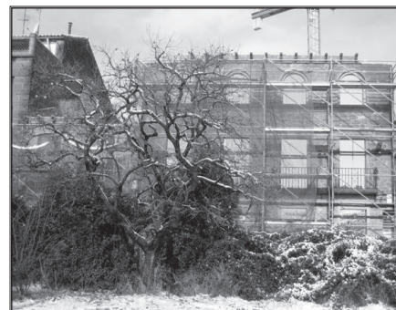
Estado actual de las obras
