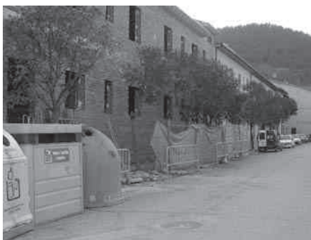
Aspecto actual de la reforma.
